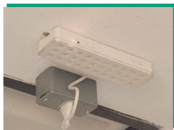
INSTALAÇÃO DE NOVA ILUMINAÇÃO E SINALIZAÇÃO DE EMERGÊNCIA
