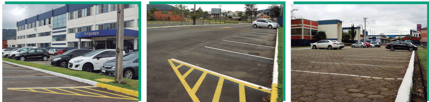
MELHORIA NA SINALIZAÇÃO DOS ESTACIONAMENTOS DOS PRÉDIOS FRANCISCO CLÈVE E SEDE
