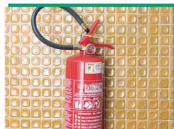
SUBSTITUIÇÃO DOS EXTINTORES PARA O PADRÃO ABC
