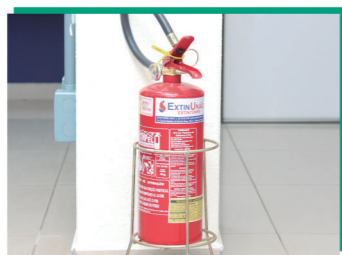
SUBSTITUIÇÃO DOS EXTINTORES PARA O PADRÃO ABC
