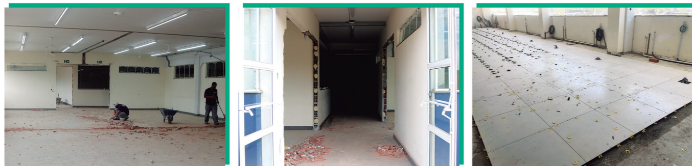
INÍCIO DAS OBRAS DA CLÍNICA ODONTOLÓGICA DA UNIGUAÇU
