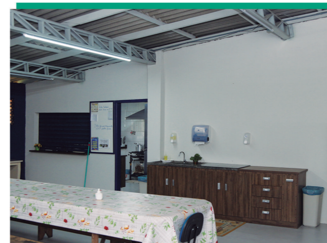
REFORMA DO REFEITÓRIO DO PRÉDIO SEDE
