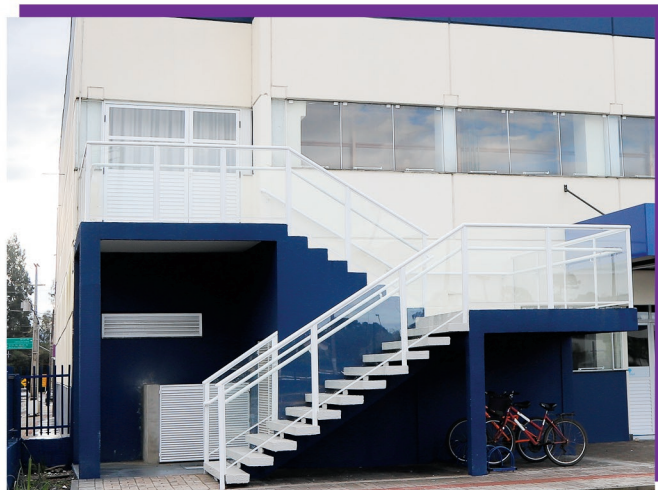
ESCALA PARA SAÍDA DE EMERGÊNCIA NO AUDITÓRIO EDSON AIRES DA SILVA, EM ADEQUAÇÃO ÀS NORMAS DE SEGURANÇA
