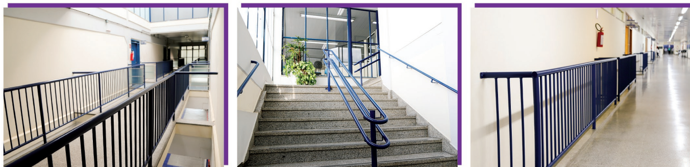
SUBSTITUIÇÃO DE GUARDA CORPO E CORRIMÃO DOS EDIFÍCIOS FRANCISCO CLÈVE E CTU
